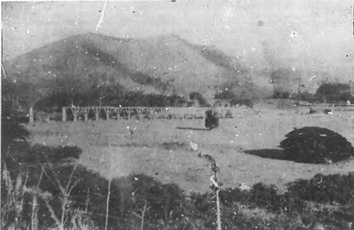
Derrumbe de un tramo del Puente, sobre el río "Tayaba".
