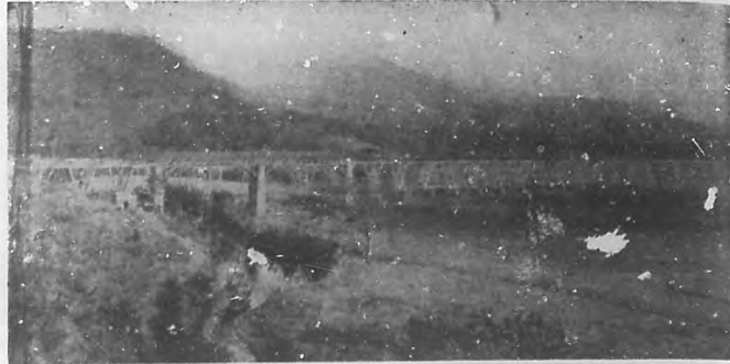
Puente sobre el río "Tayaba".
